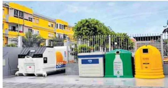
Punto de recogida con contenedores y autocompactadora. c7
