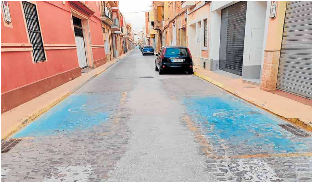
Obras de reparación del alcantarillado ejecutadas en Catarroja. LP
