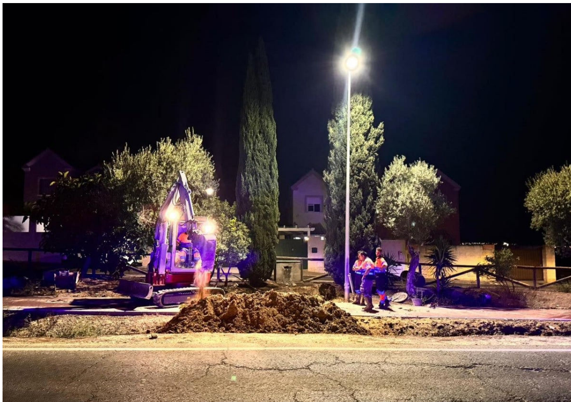
Trabajos de reparación en la tubería Ayuntamiento de espartinas
